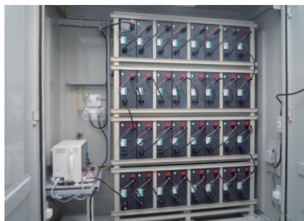
図9 UB 100-6 × 32個 九州ヒューマンメディア創造センターにて Fig.9 UB100-6×32 cells at Human Media Creation Center
