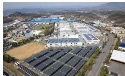
いわき事業所の太陽光パネル
