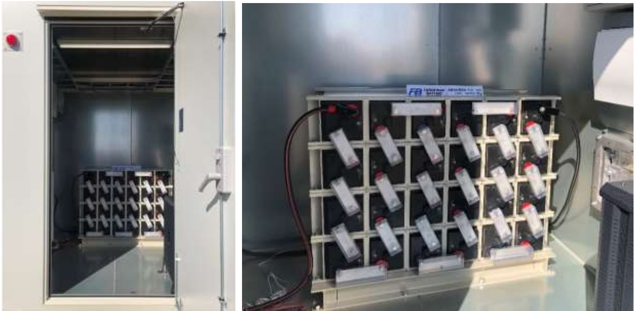
「サステナブル・エネルギーソリューション」内に設置されたサイクルユース用鉛蓄電池 FCP-500
