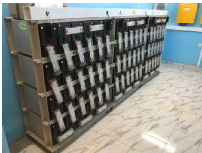
蓄電システムに組み込まれたサイクルユース用鉛蓄電池 FCP-1000
