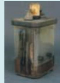
日本初のガスフィルターを装置した硝子槽入密閉型据置蓄電池の実用化に成功
