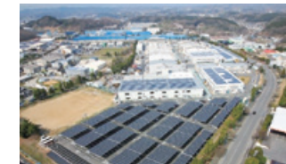
太陽光発電設備導入 いわき事業所（福島県いわき市）
