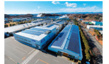
いわき事業所 新工場建屋 (フタバコンサルタンツ株式会社 撮影)
