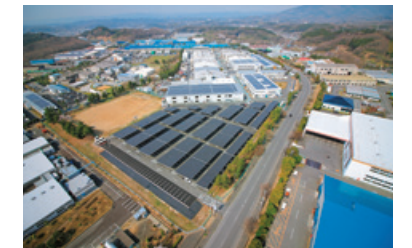
いわき事業所太陽光発電設備
