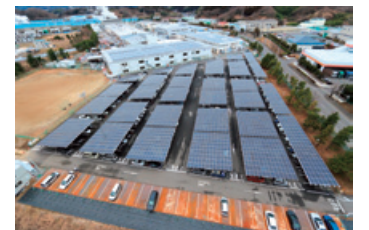
いわき事業所太陽光発電設備 (写真: フタバコンサルタン株式会社撮影)
