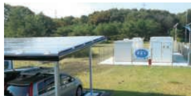
カーポートの屋根に設置したソーラーパネルと多並列蓄電システム (エフビー工場)
