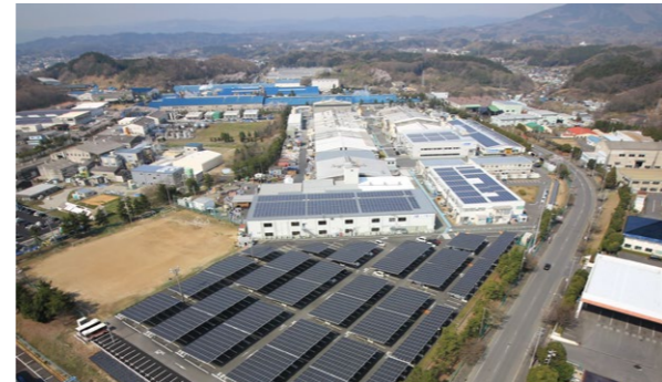
太陽光発電設備導入済み生産拠点 いわき事業所(福島県いわき市)
