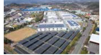
太陽光発電設備導入 いわき事業所(福島県いわき市)
