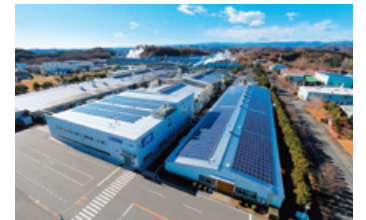
いわき事業所 新工場建屋
