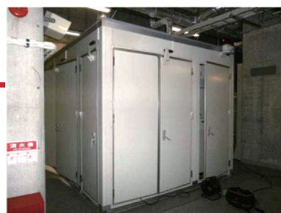
30kW用次世代リチウムイオン電池蓄電設備
