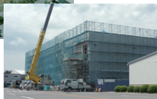
工場建屋増設の様子
