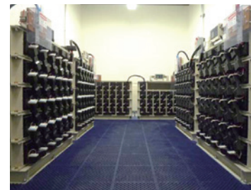
90kW先進鉛蓄電池設備 (アルバカーキ市商業ビル)
