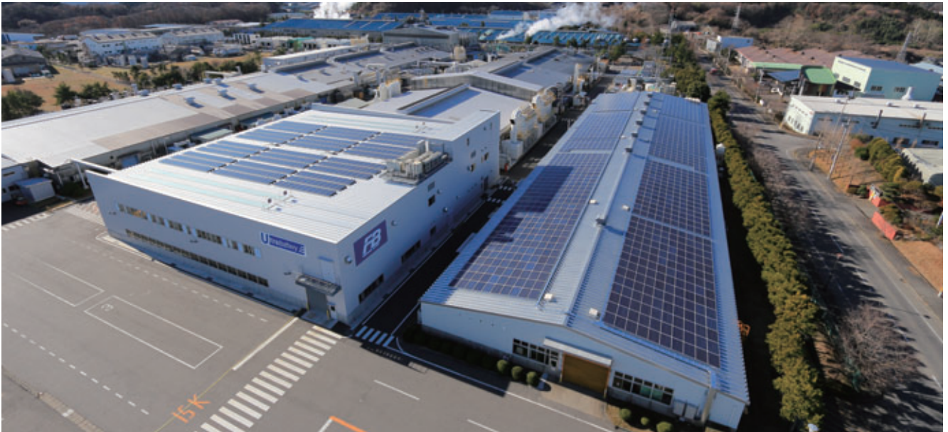
工場屋根の太陽光発電パネル(写真:フタバコンサルタン株式会社撮影)
