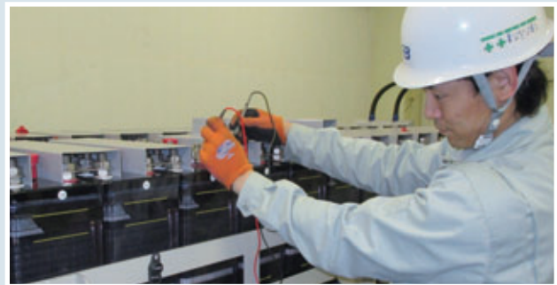
点検作業の様子
